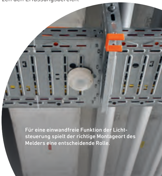
Abb. 1: Ein PIR- Melder schaltet bei seitlichem Vorbeigehen, bedeutend früher als bei direktem Draufzugehen.
